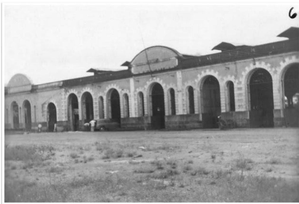
Figura 3 – Oficina de manutenção dos trens
