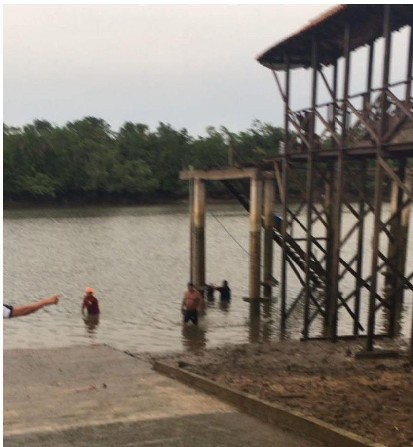
Figura 8 – Píer em construção no Bairro planejado Reserva Jardim
